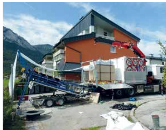
Ein Spezialgerät im Einsatz in der Jellmollistraße. Bild: RHV
