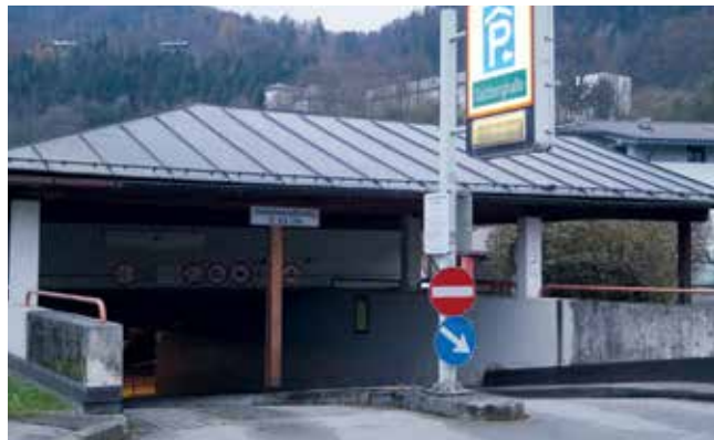
Unser Bild zeigt die Parkgarageneinfahrt bei der Salzberghalle.
