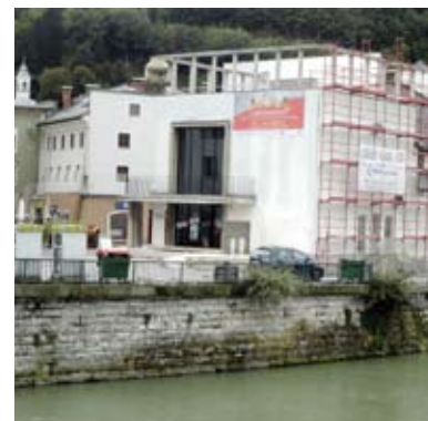
STADTKINO : SANIERUNGSARBEITEN VOLL IM ZEITPLAN
